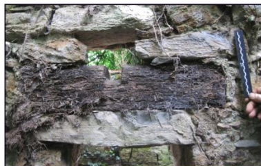
A Vue de la façade ouest. La pièce en bois avec échancrure pour levage des seaux
