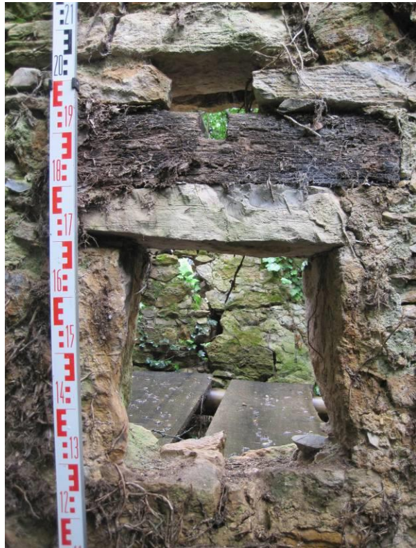
Face coté est du MUR 5
