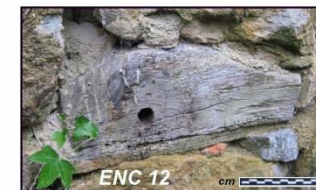
Faisant vis-à-vis avec la pièce B sur le MUR 2, la deuxième encoche recevant l'axe du treuil (la pièce en bois manque)
