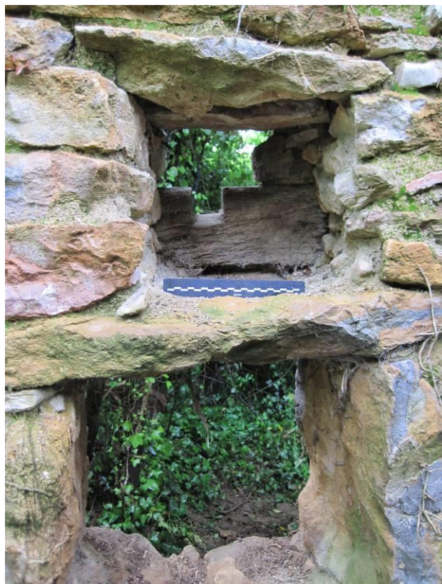
Face coté ouest du MUR 5
