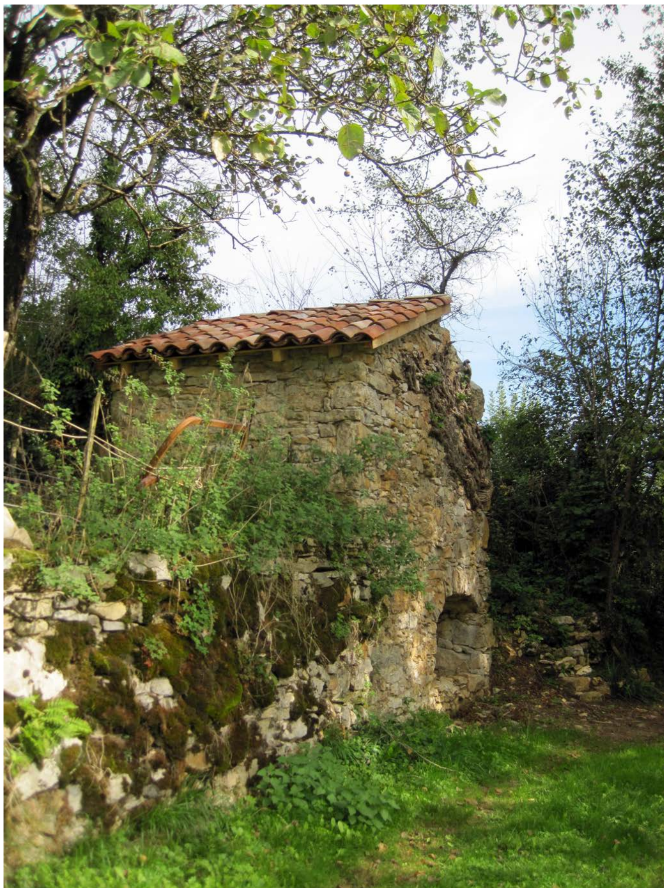
Le puit de Ponsic après sa restauration par la Mairie de Cadarcet en 2013
