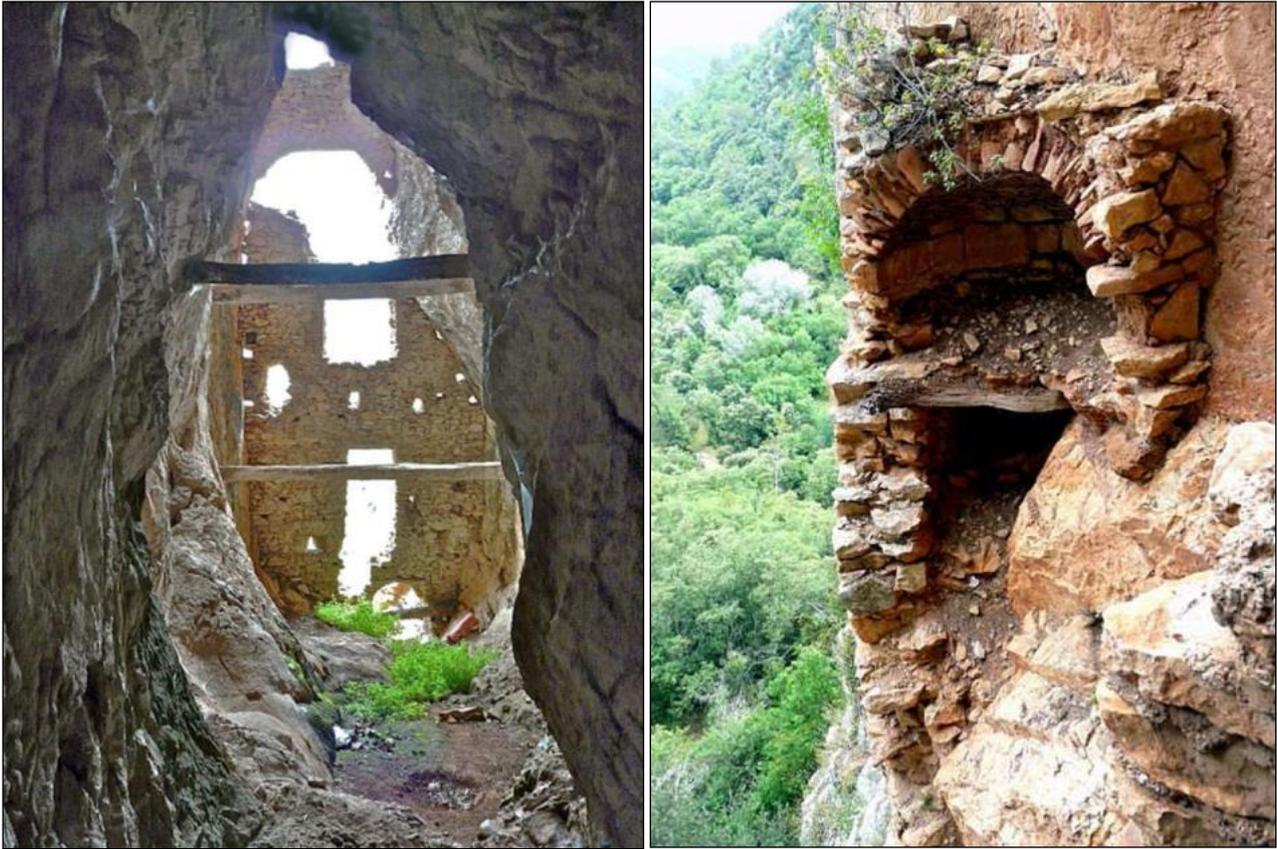
**1**-La façade vue de l'intérieur. La poutre du bas supportait le plancher du niveau 2, les deux poutres au-dessus celui du niveau 3. Les autres trous qui auraient pu marquer les niveaux 4 et 5 sont trop loin pour être vus en toute certitude.
