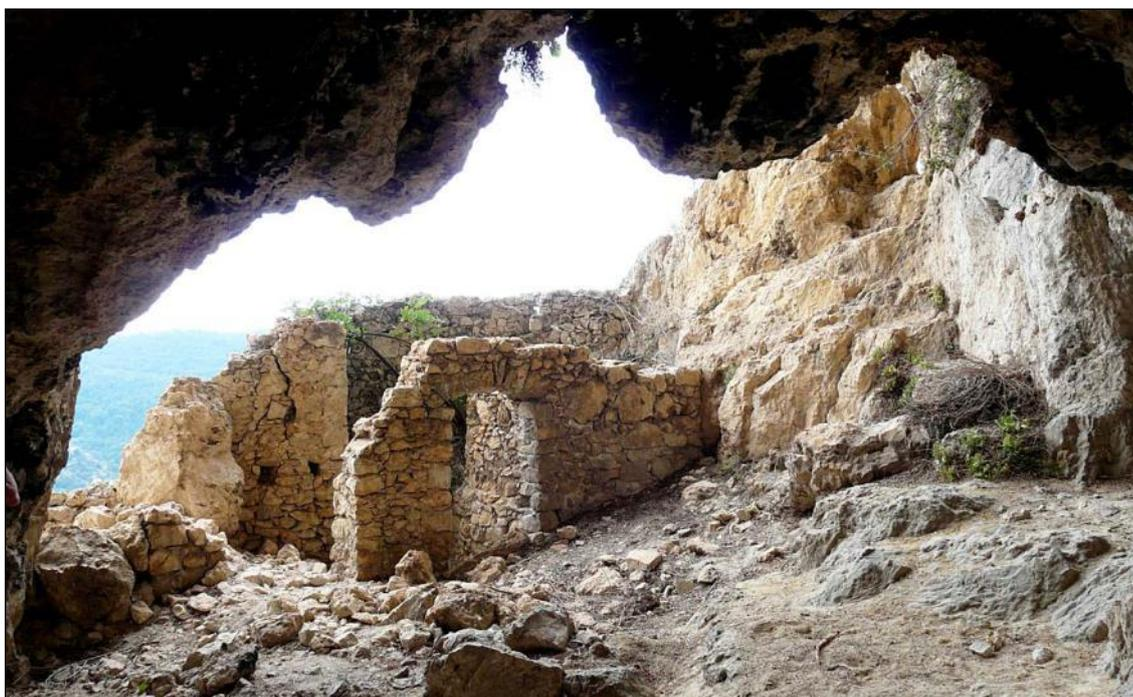
*La fortification vue de la grotte. Au fond, on distingue le bastion. On distingue aussi les deux murailles endommagées par un éboulement. La muraille intérieure a été percée de portes, elle permettait de soutenir une terrasse. A droite, les marches menant à la terrasse supérieure.*
