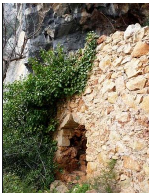
Porte d'entrée de la 121P, haute de 1,30m.
