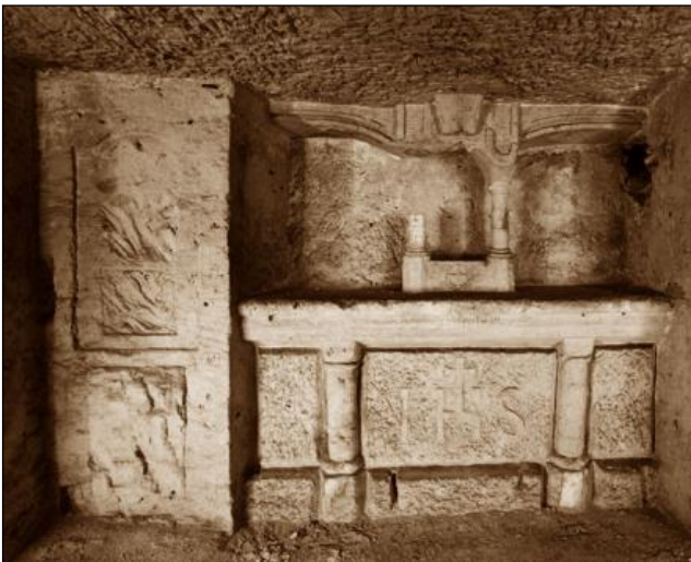
Le vandalisme de l'autel est-il à mettre au compte des soldats français, ou à une trop grande pression de la voûte, pour ce qui concerne la colonne ?
